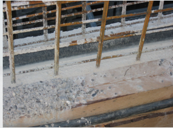
Wand-Deckenverbindung mit TopFuge TF 120
