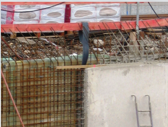
Wand-Wandverbindung mit TopFuge TF 120
