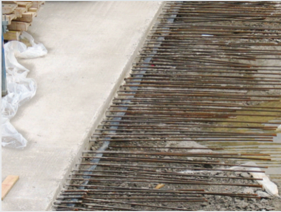
Boden-Bodenverbindung mit TopFuge TF 240
