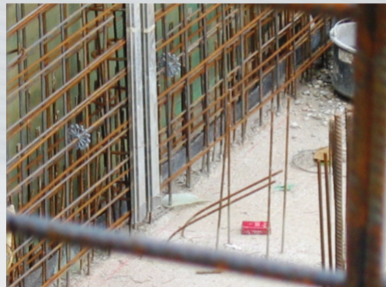
Boden-Wandverbindung mit TopFuge TF 190
