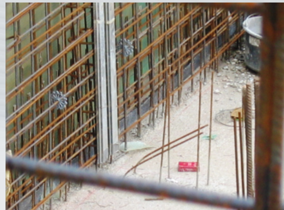
Boden-Wandverbindung mit TopFuge TF 190
