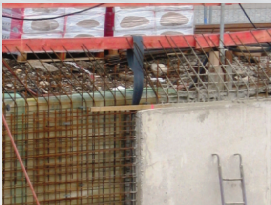
Wand-Wandverbindung mit TopFuge TF 120
