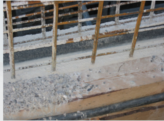
Wand-Deckenverbindung mit TopFuge TF 120
