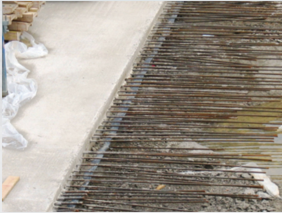
Boden-Bodenverbindung mit TopFuge TF 240
