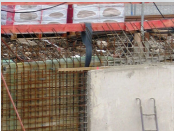
Wand-Wandverbindung mit TOPFUGE TF 120
