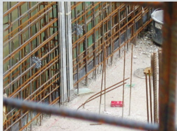
Boden-Wandverbindung mit TOPFUGE TF 190
