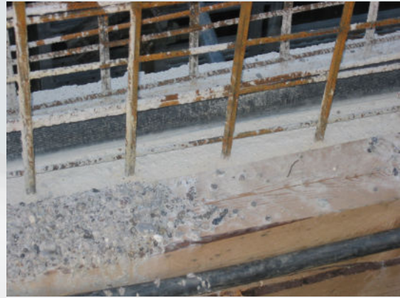
Wand-Deckenverbindung mit TOPFUGE TF 120
