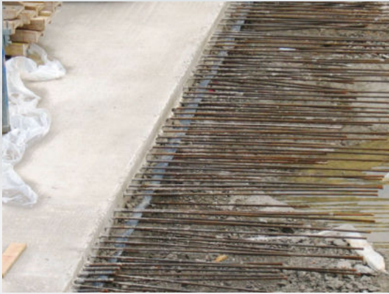
Boden-Bodenverbindung mit TOPFUGE TF 240
